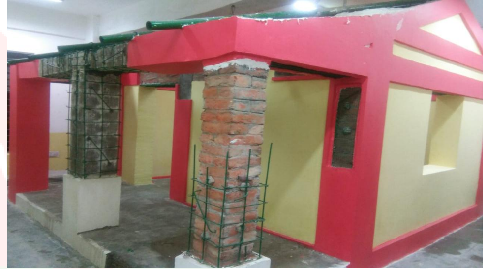
वर्तमान भवन का सुदृढ़ीकरण
